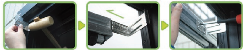
1. プラケット(取付金具)を窓枠サッシの両側に取付けます。 2. 本体の裏側の溝にプラケットを差込みます。 3. 本体とプラケットの位置を確認し、ビスをしっかりと固定します。
